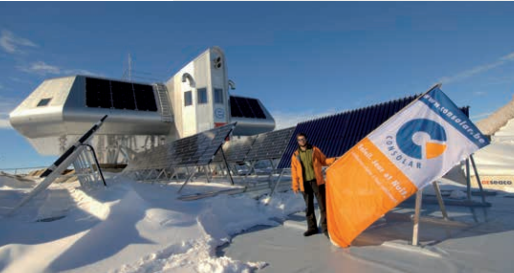
L'énergie nécessaire aux besoins électriques et de chauffage de la station scientifique „Princess Elisabeth“ en Antarctique provient exclusivement du soleil.
